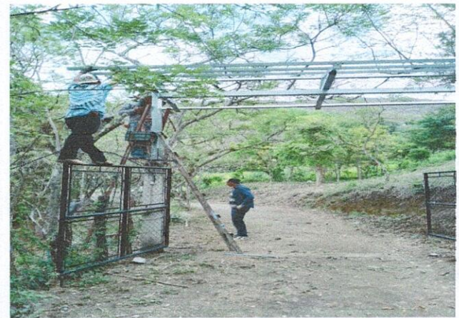
Foto 4: Mantenimiento a portones
