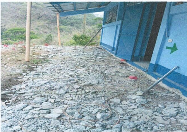
Foto 3: Losa de patio
