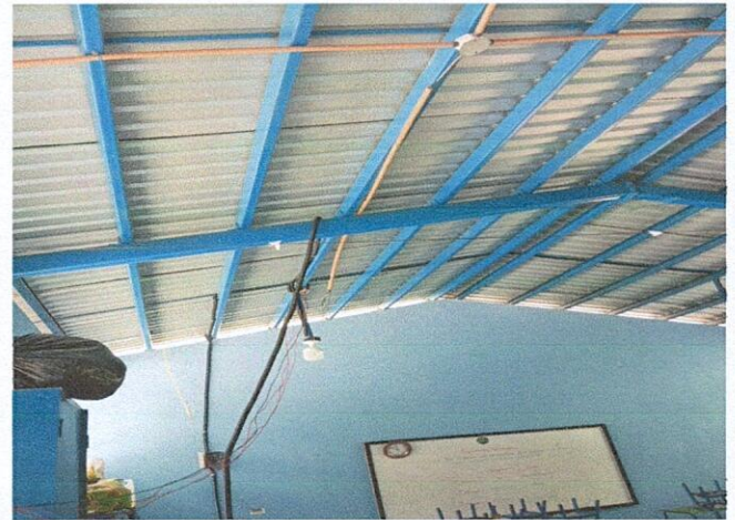
Foto 2: Reparación de sistema eléctrico
